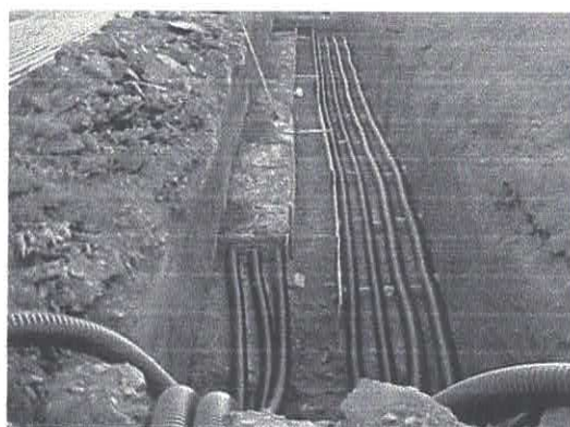
FIGURA 1 -ELETRODUTOS ENVELOPADOS
